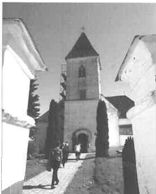
Svētdienās uz dievkalpojumu Alsungas katoļu baznīcā sanākot ap 60 cilvēku.
