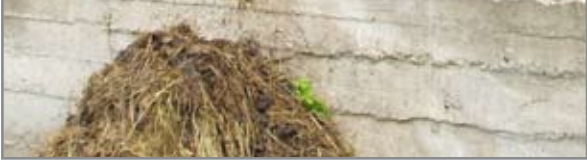
Sīkrags. Kīrslauku bij.Vecvalki kūts pamati. laukakmens mūrējums (atjaunots, nostiprinot ar cementa javu)
