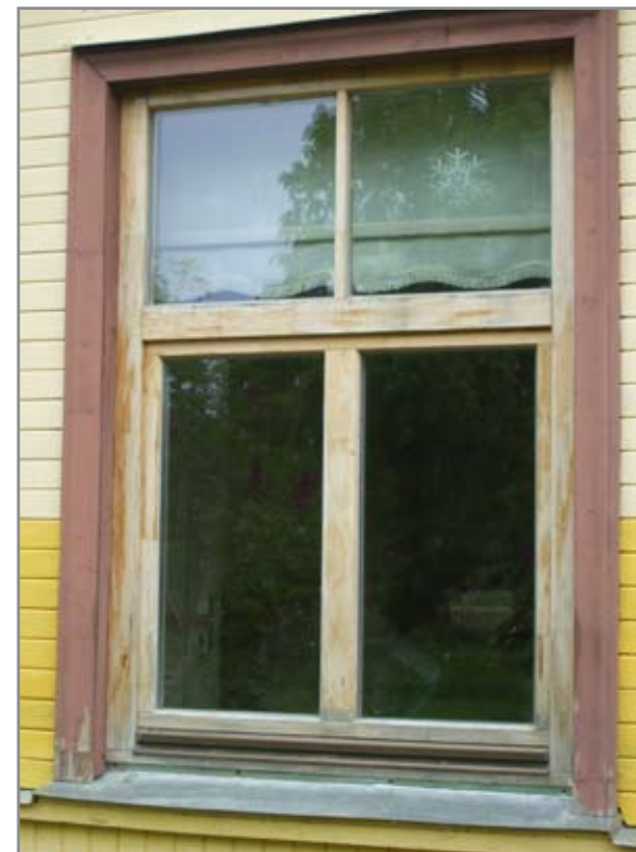
Sikrags, Jaunklāvu dzīvojamās mājas logs nomainīts, saglabājot vēsturisko dalījumu
