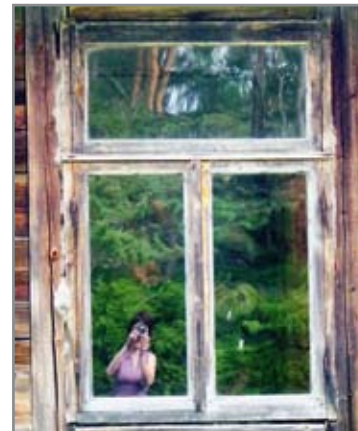
Mazirbes dzīvojamās mājas logs- T veida konstrukcijā
