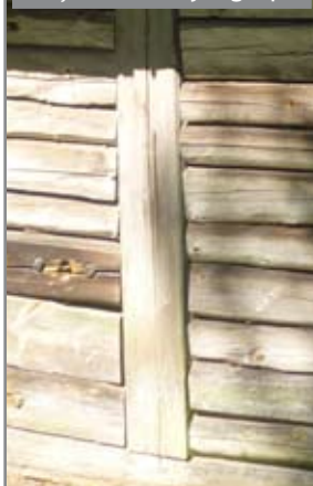
Saunags. Jūrnieku kūts sienu, baļķu salaiduma vieta šķautņu gali ielaisti statņu vertikālajās gropēs
