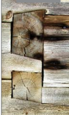
Košrags, Baznīckalnu kūts sienu baļķu salaiduma vieta
