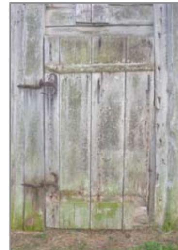
Mazirbe, saimniecības ēkas dēļu durvis ar kaltām eņģēm
