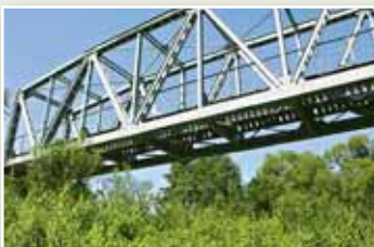
Rīgas – Ērgļu dzelzceļa tilts
