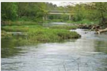
Grobiņas – Rucavas ceļa tilts
