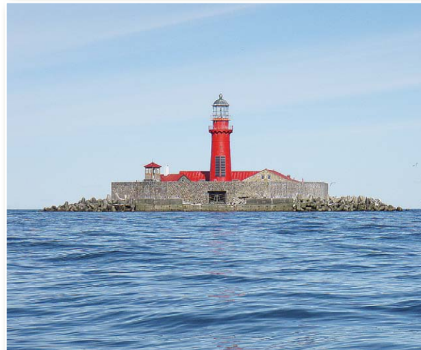
Leuchtturm von Kolka
