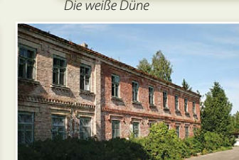
Das ehemalige Gebäude der Meeresschule
