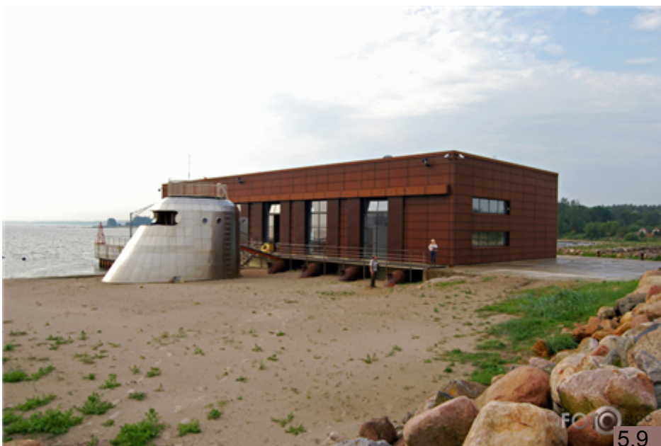
Sūkņu stacijas pārbūve par dzīvojamo māju
