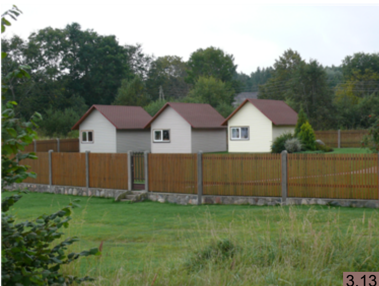
3.13.att.: nevēlams, neraksturīgs krāsu pielietojums, kā arī būvapjomu izvietojums, proporcijas un žoga risinājums
